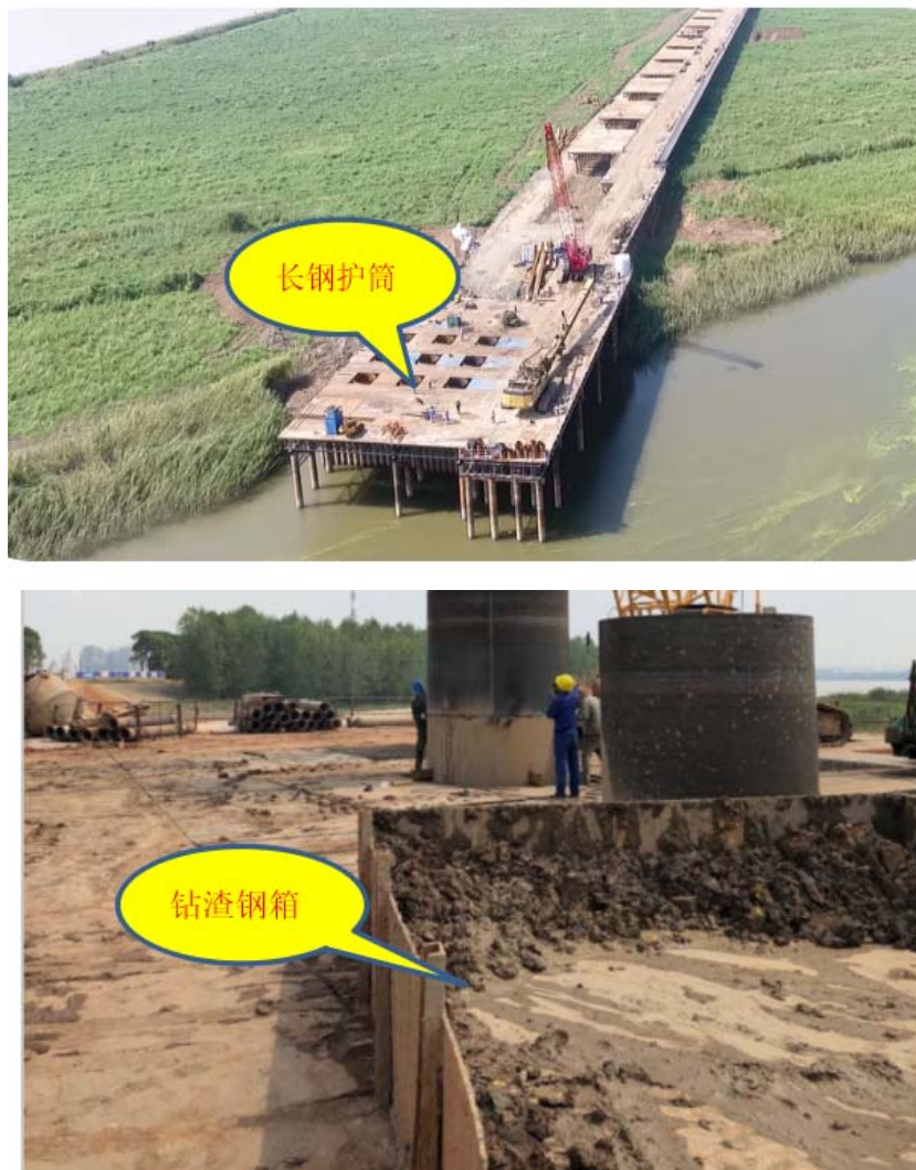
图 6.7-3 水源保护区水域内施工防护措施现场图
