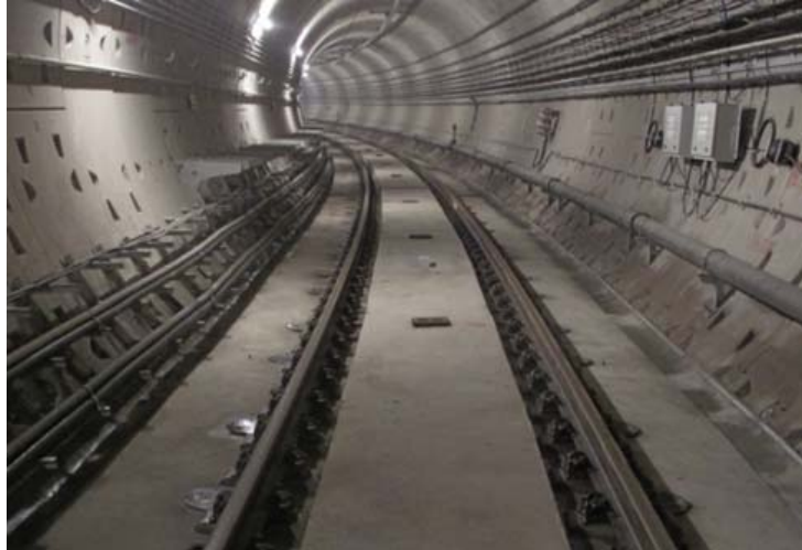
图 5.5-7 固体阻尼钢弹簧浮置板道床
