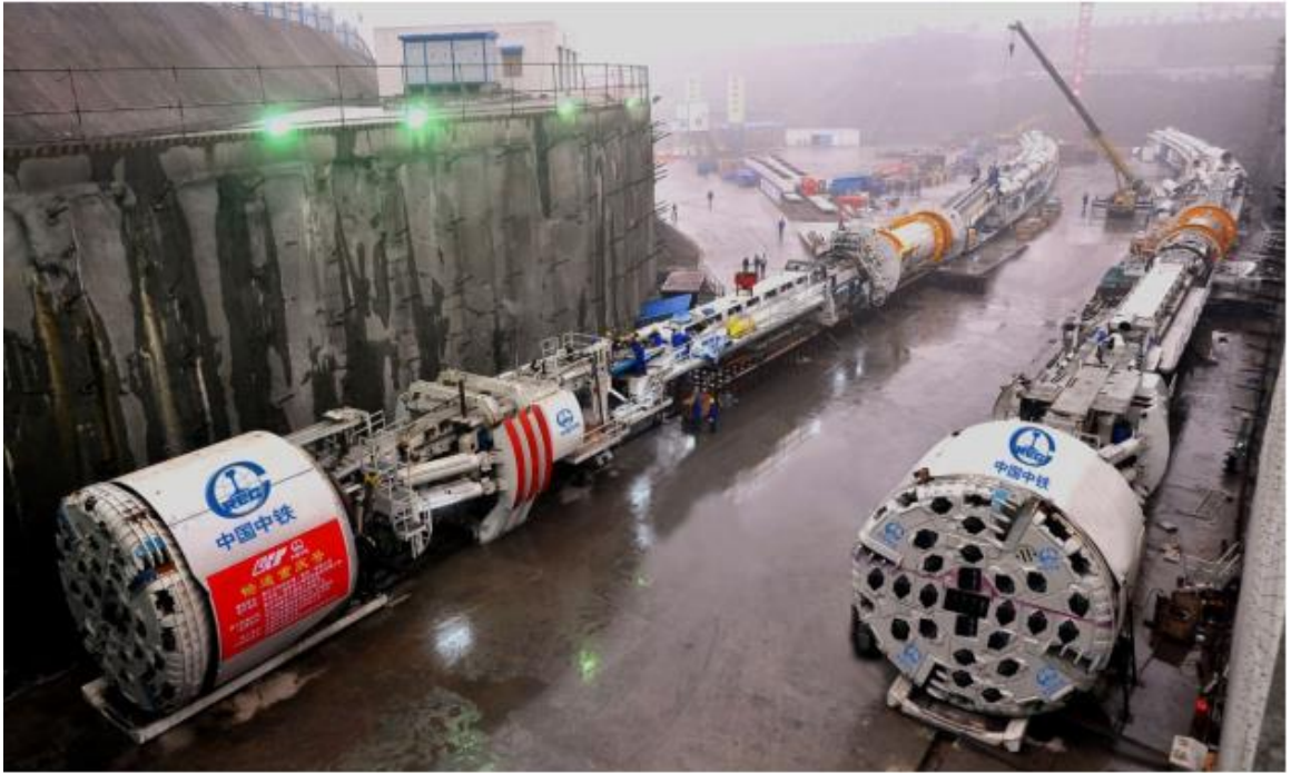
图 2.1-14 TBM 法施工设备
