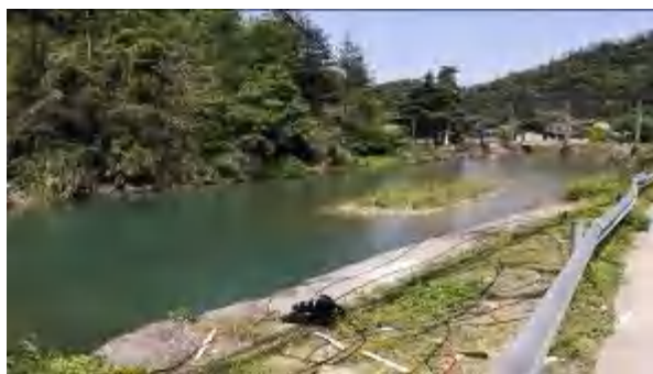
竹溪源溢洪道
