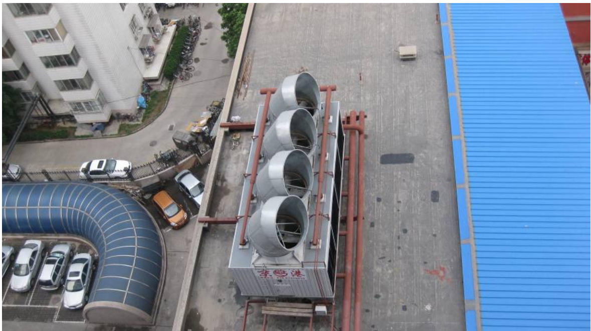
图 4.5-1 冷却塔导向消声器实施实例
